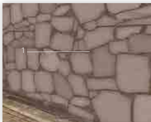
Ristilatura dei giunti.
