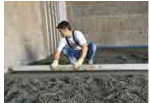
Massetto per pavimentazioni di coperture e terrazzi.
